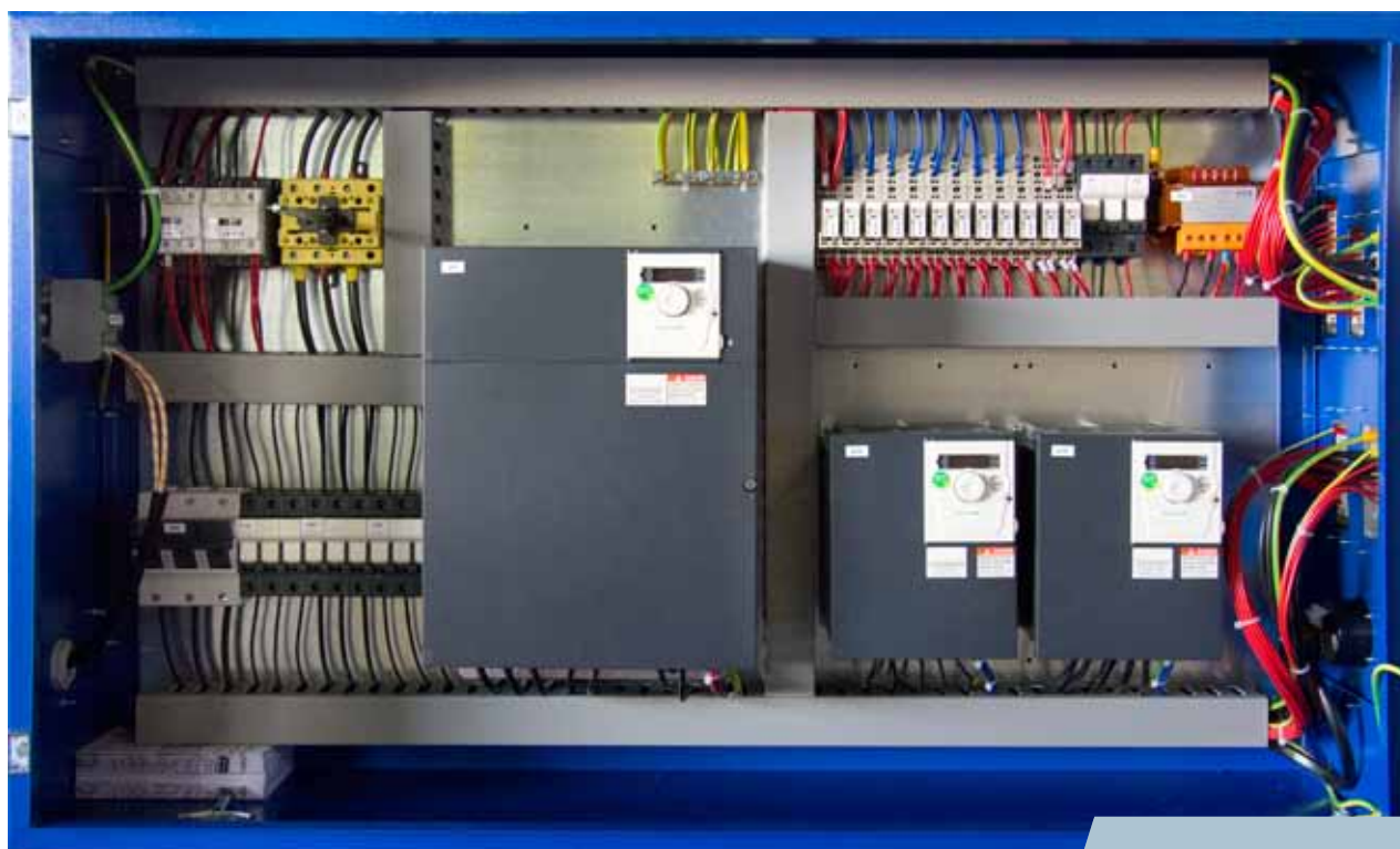
Quadro elettrico a connettori per carro ponte con inverter sollevamento, scorrimento ponte, traslazione carro
