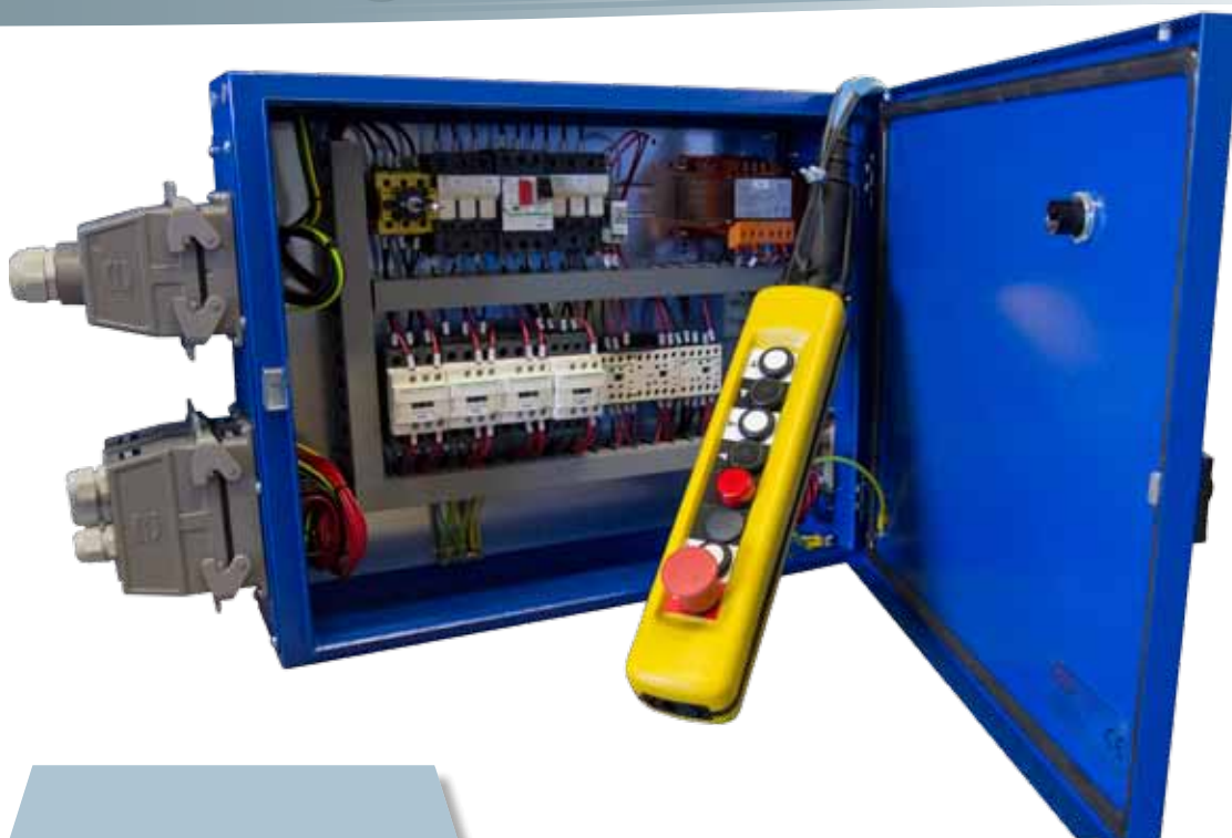
Quadro elettrico con connettori per carrelli paranco
