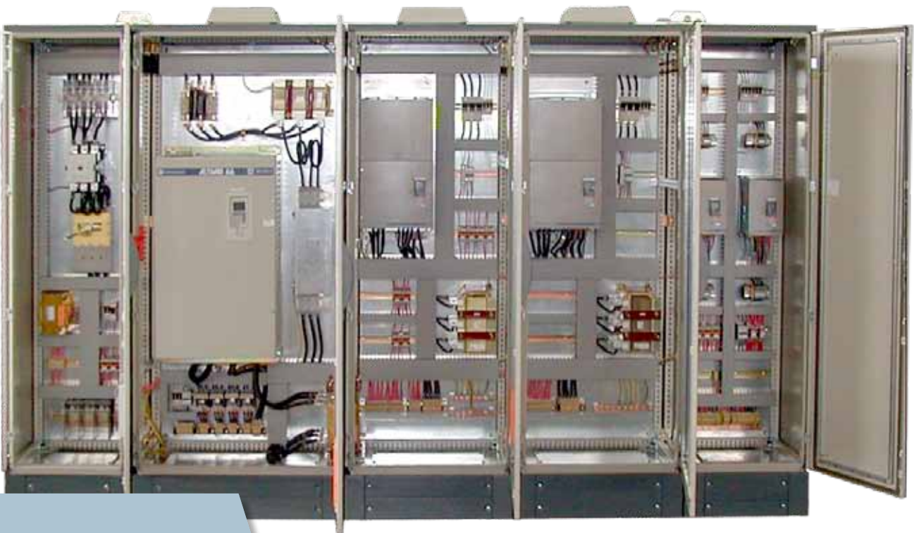
Quadro elettrico per carro ponte speciale con inverter di sollevamento da 132 kW
