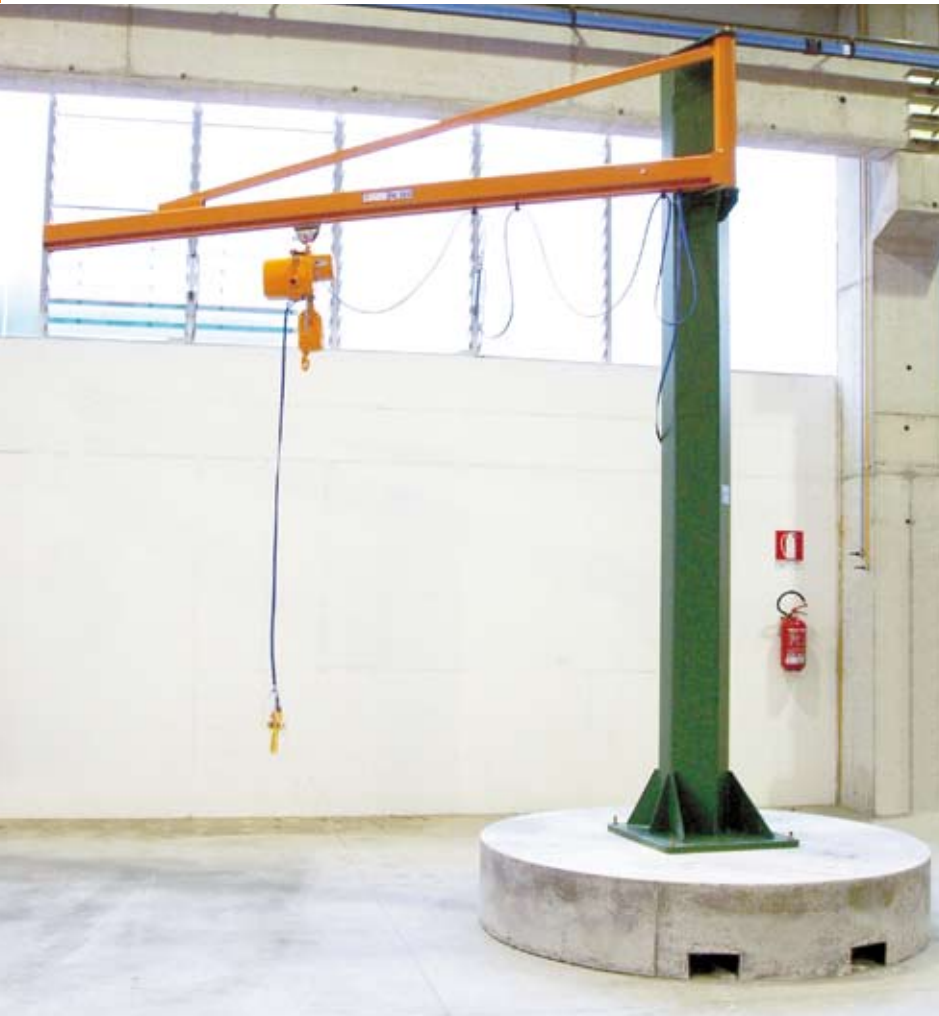
Gru su plinto spostabile realizzato in c.a.
